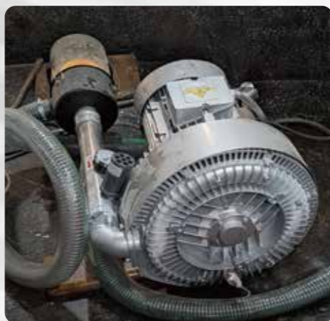
強力ポンプで吸引する大型バキュームポンプ
